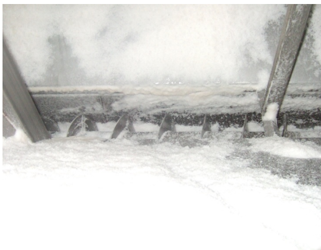
Bilde 7: Skrue som overfører salt til kar
